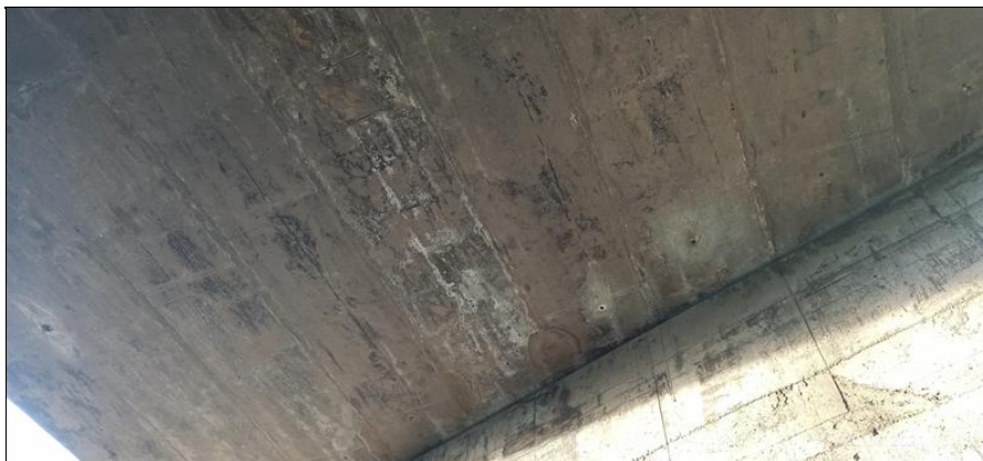
21. Vápenné výluhy na podhledu.jpg
