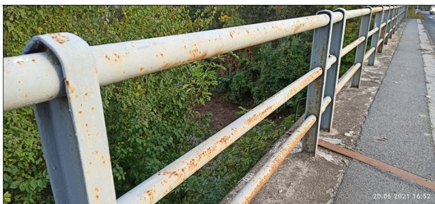
06.Koroze zábradlí.jpg
