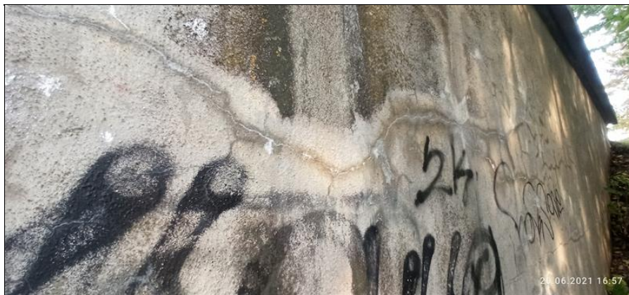
25.Vodorovná trhlina na OP2 vpravo.jpg
