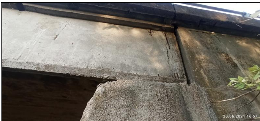
24. Obnažené výztuže NK z boku vpravo u OP2.jpg
